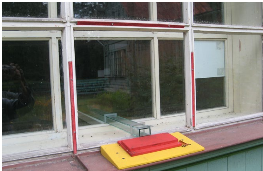
Рис. 6. Тоннель проходит через два стекла, снабженных силиконовыми прокладками. Фото: А. Наполов / Fig. 6. The tunnel passes through two glasses, equipped with silicone gaskets. Photo by: A. Napolov
