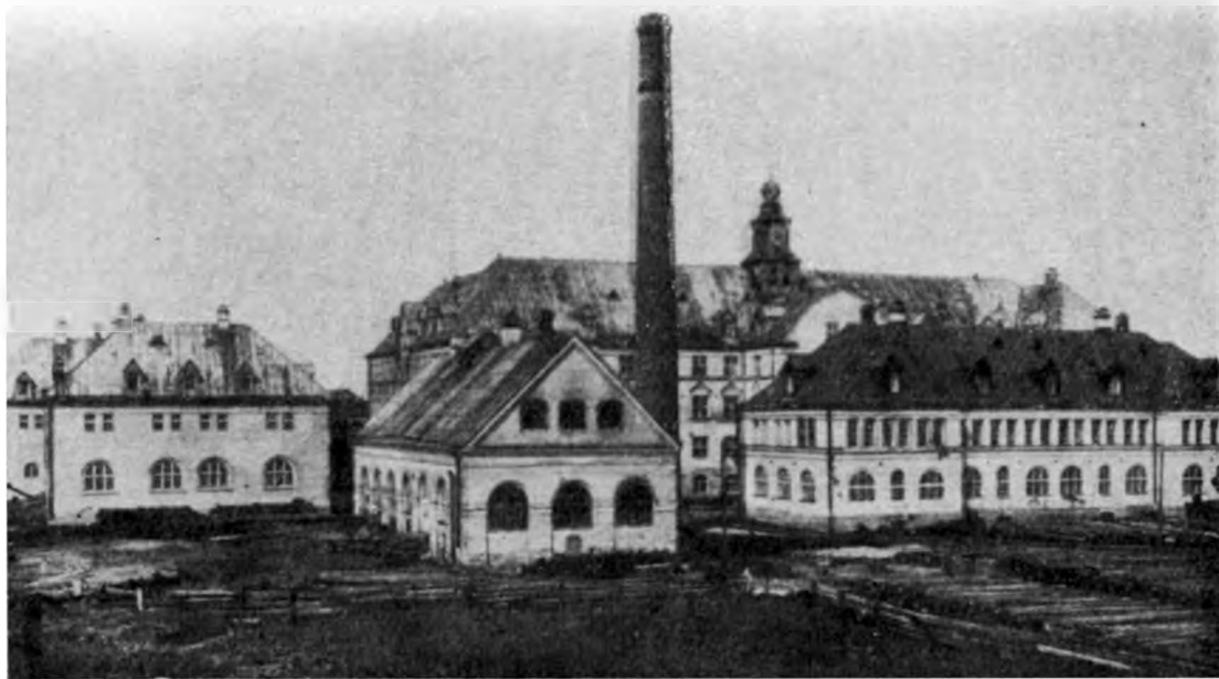
Здания, пожертвованные Н. В. Мешковым для Пермского университета. На переднем плане — электростанция; в средней части правого здания во втором этаже была квартира А. А. За-варзина.
